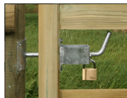
Lukketøy i grindrammen
