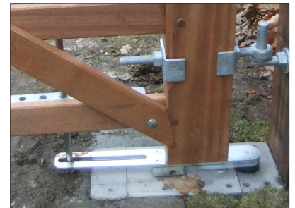
Velegnet til portautomatikk. Her vist med motor til nedstøpning.
