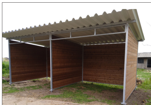
Skillevegg montert i leskur
